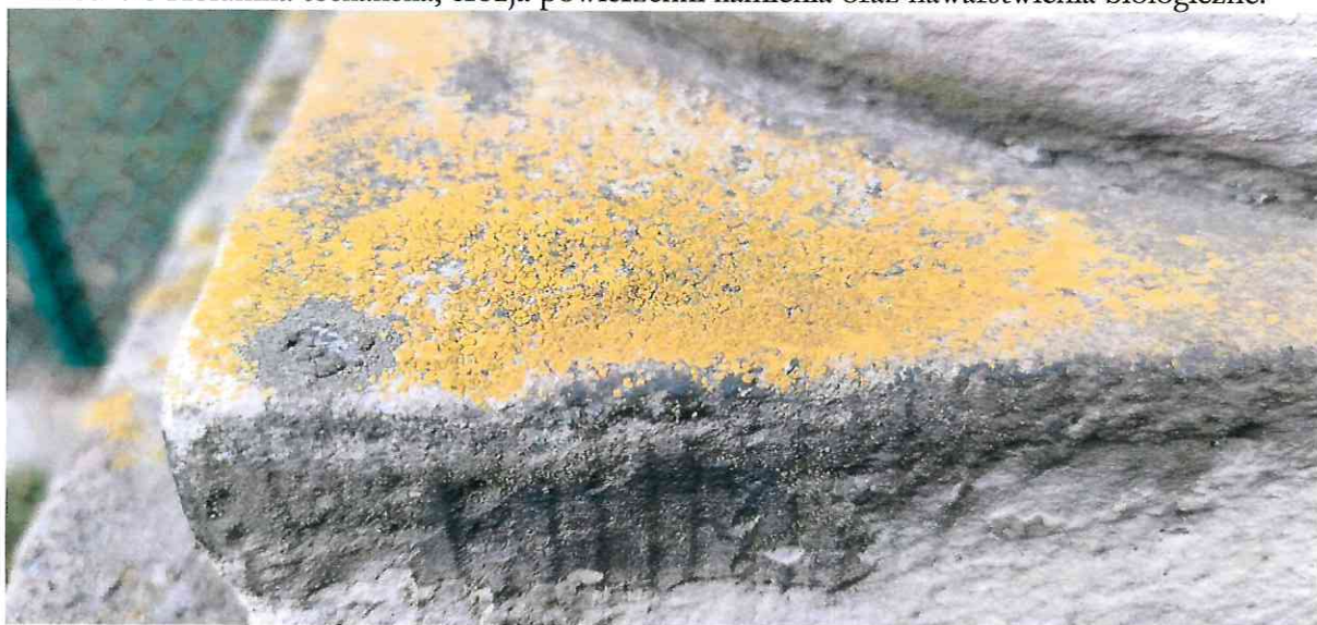
Fot. 4-6 Kolumna toskańska, erozja powierzchni kamienia oraz nawarstwienia biologiczne.
