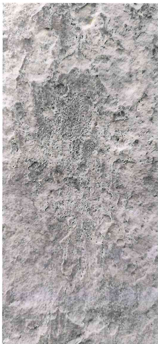
Fot. 4-6 Kolumna toskańska, erozja powierzchni kamienia oraz nawarstwienia biologiczne.
