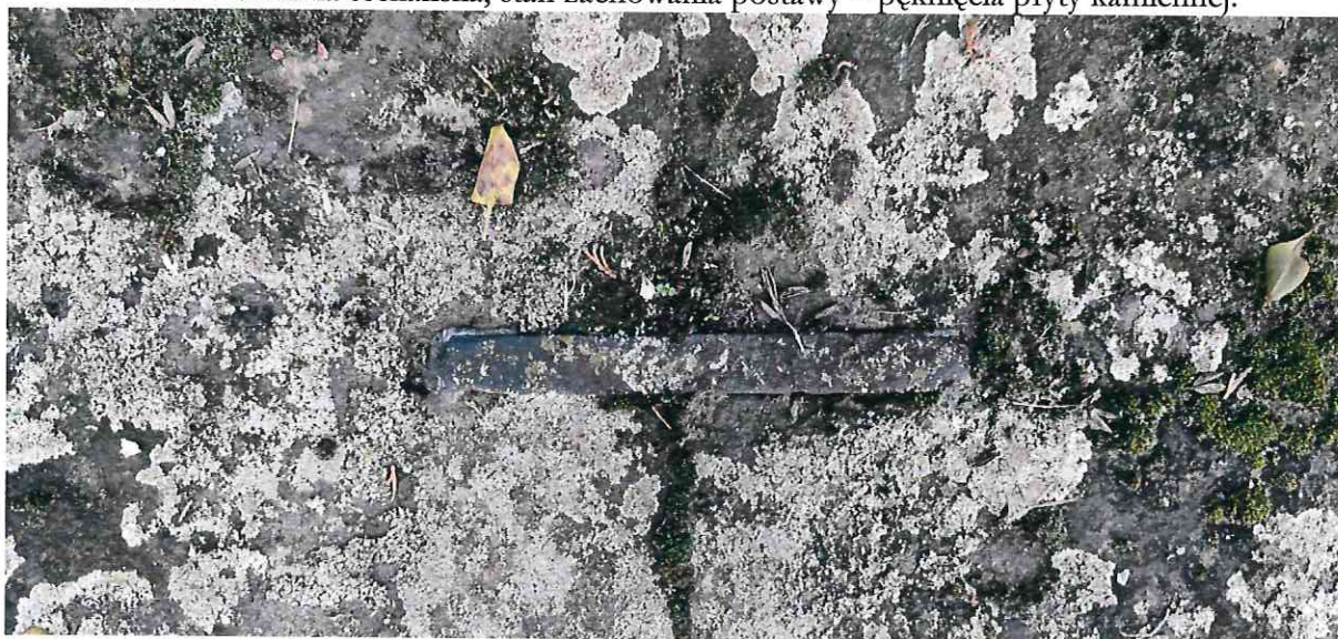
Fot. 20 Kolumna toskańska, łączenia elementów podstawy.
