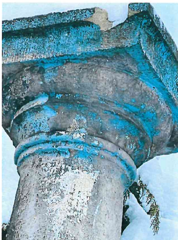
Zdj. 8 – Ubytek w górnej części kolumny
