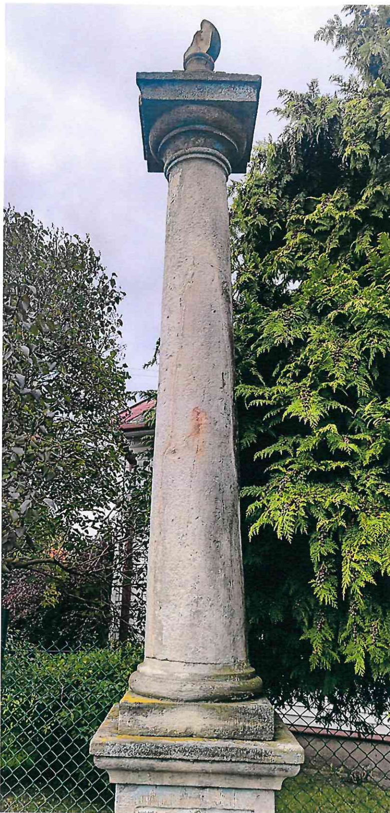
Fot. 3 Kolumna toskańska, trzon z widoczną erozją kamienia.
