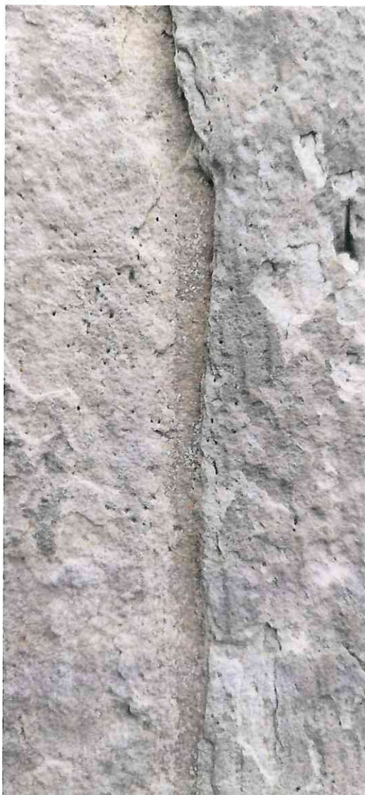
Fot. 4-6 Kolumna toskańska, erozja powierzchni kamienia oraz nawarstwienia biologiczne.
