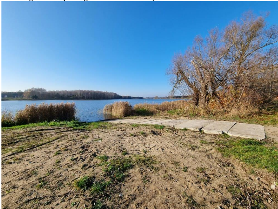
Fotografia 13. Zdegradowany brzeg Zalewu w Drzewicy
