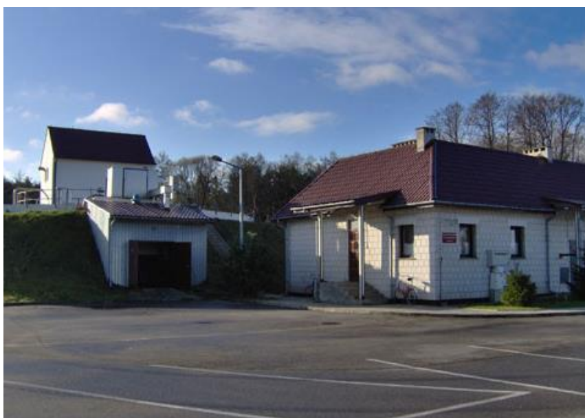
Oczyszczalnia ścieków w Drzewicy, ul. Słowackiego 26
