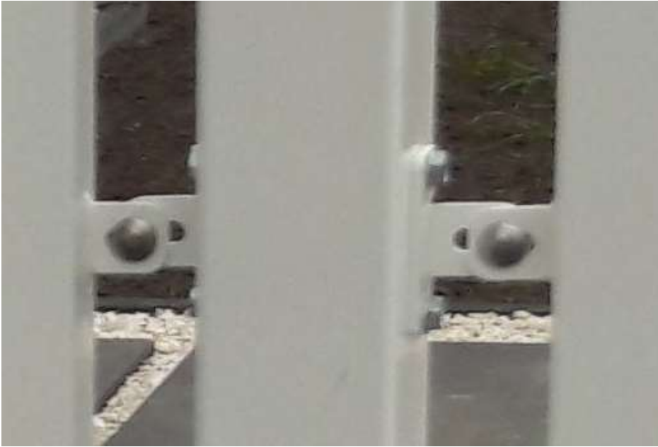
Fot. 3 Przykład połączenia przesył ze słupkiem.
