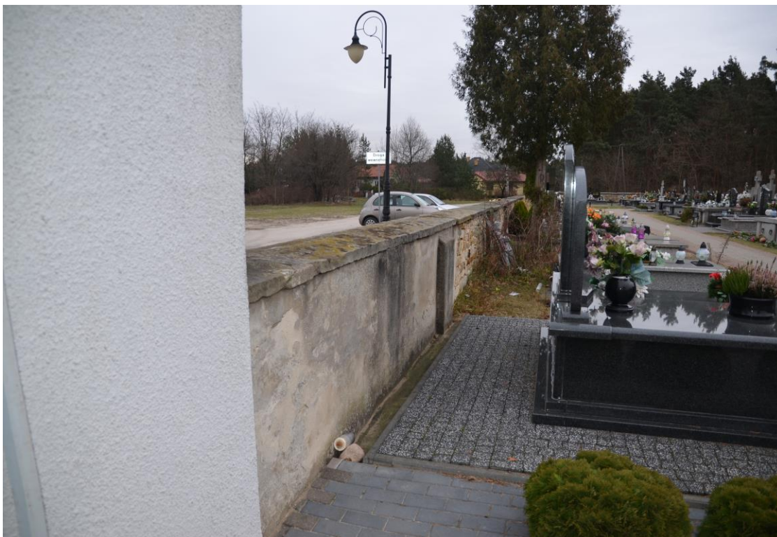
Fot. 5 Mur cmentarza – część północna, widok od strony wewnętrznej.
