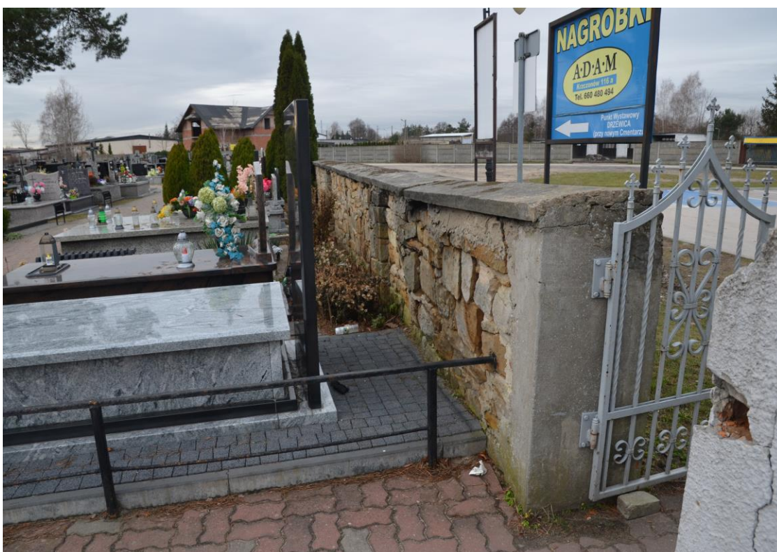
Fot. 6 Mur cmentarza – część północna, widok od strony wewnętrznej.
