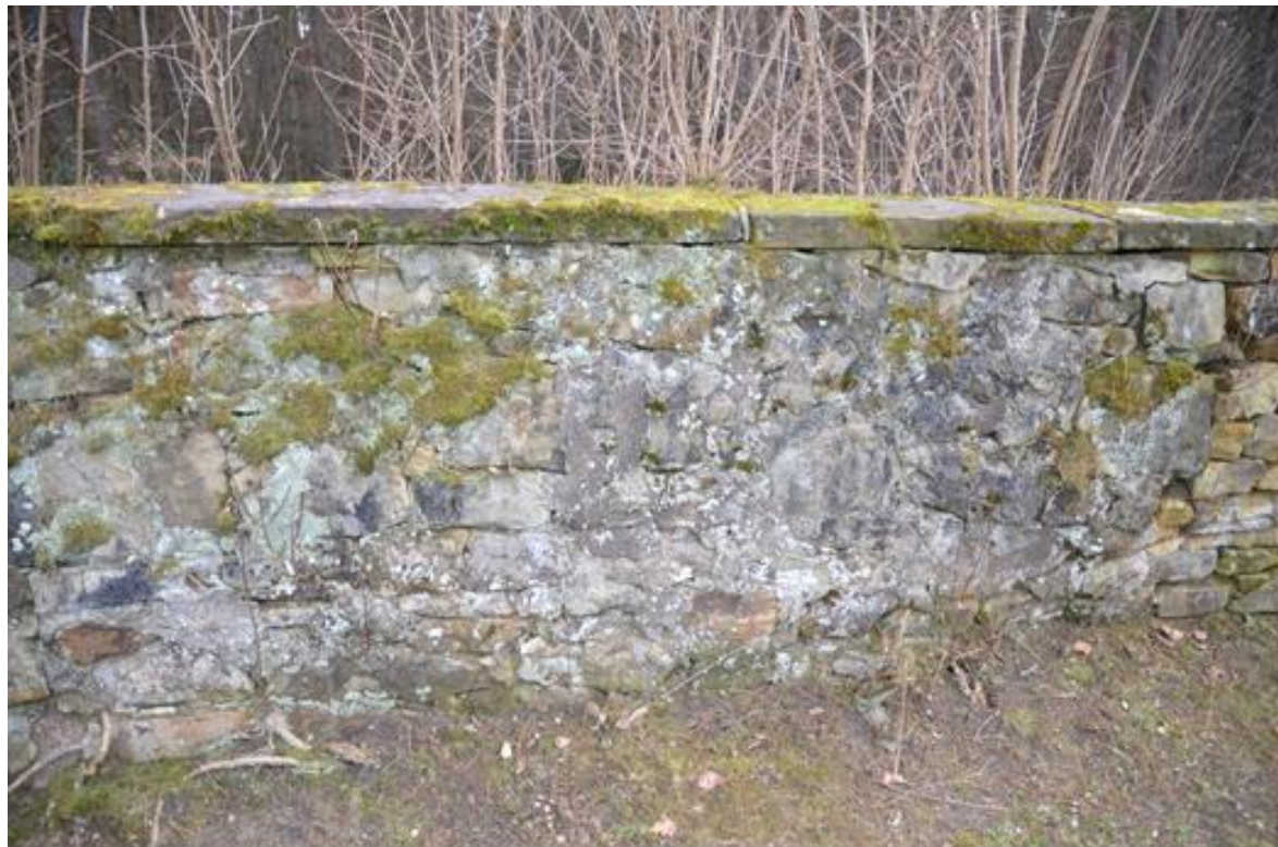
Fot. 15. Mur cmentarza, wtórne uzupełnienia zaprawę cementową – część południowa, widok od strony wewnętrznej.
