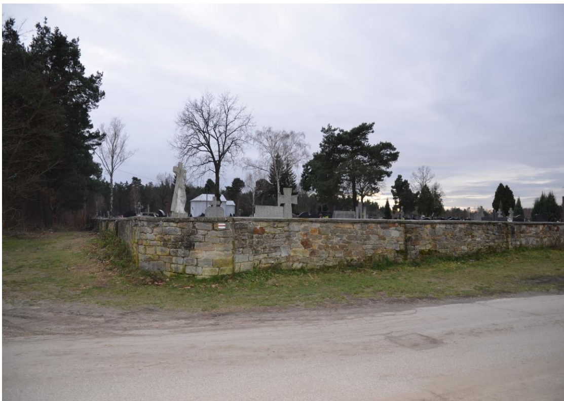
Fot. 1. Mur cmentarza – naroże północno - wschodnie.
