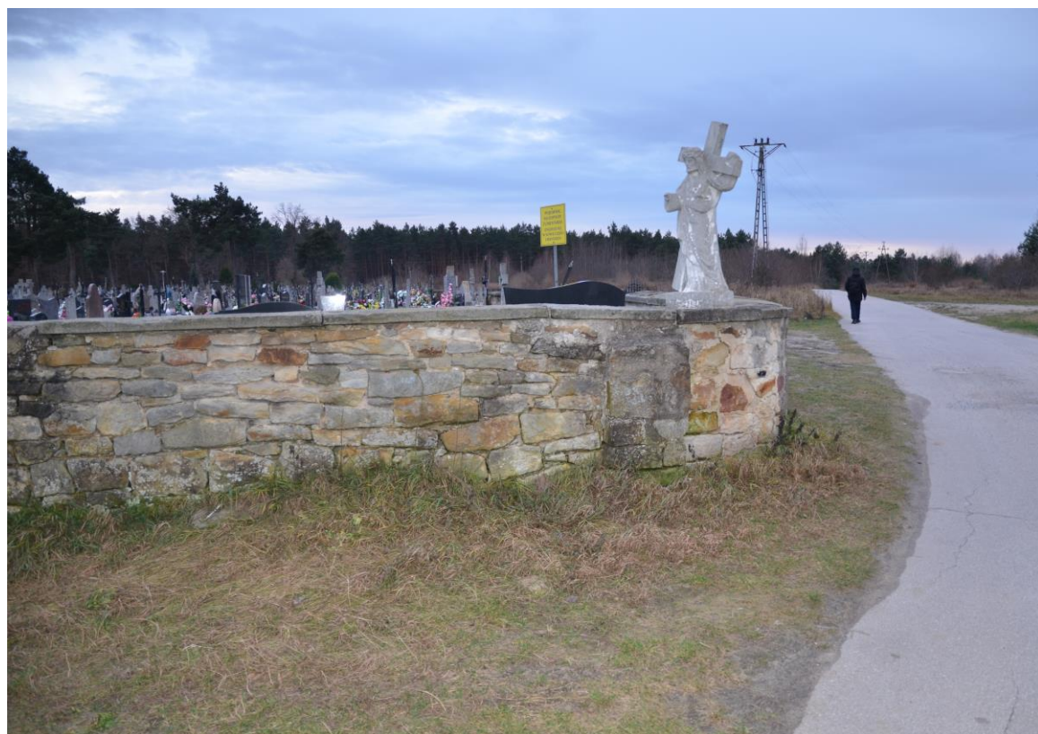
Fot. 4 Mur cmentarza – naroże północno-zachodnia.
