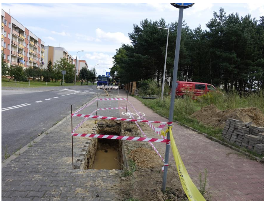
Fot. Budowa linii gazowej na ul. Stawowej. Źródło: materiały własne UM w Drzewicy
