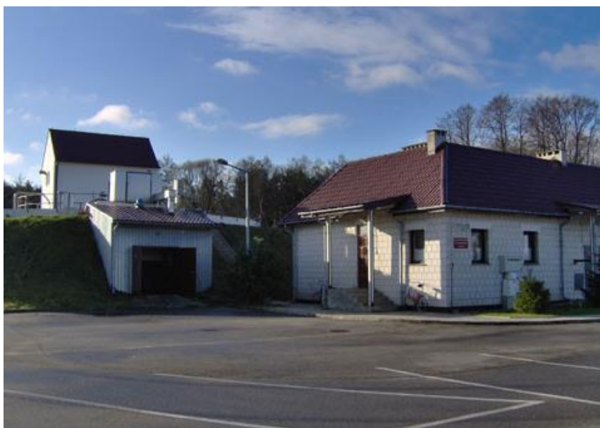
Oczyszczalnia ścieków w Drzewicy, ul. Słowackiego 26
